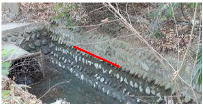
3. 流入口下流の暗渠入り口
