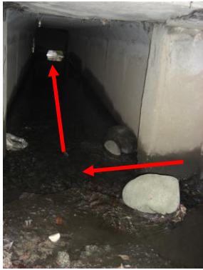
若葉町境暗渠内
