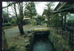
No. 54 砂川分水の開渠遺構
