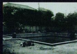
No. 89 千川上水沈砂池等遺構
